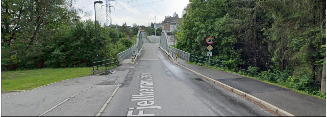
Figur 7-8: Fjellhamar bru (Illustrasjon: Google Street View, datert juni 2024)
