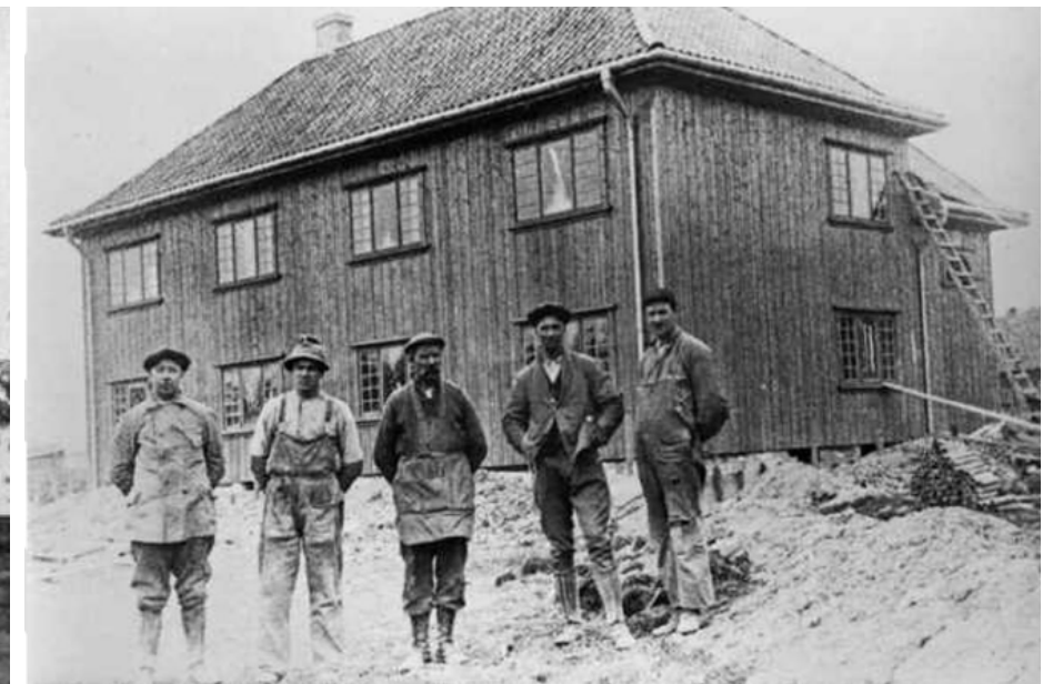
Bygningsarbeiderne poserer foran nybygget lærerbolig i 1923. (foto: Akershusbasen).
