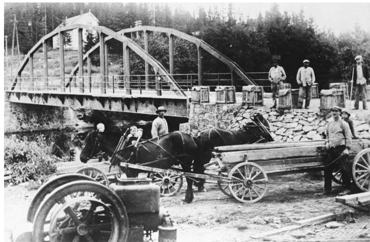
Bygging av ny Fjellhamar bru i 1925 (foto: Akershusbasen)
