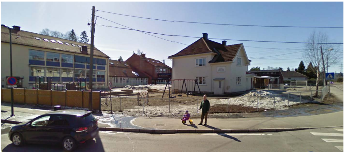
Fjellhamar skole i krysset mellom Fjellhamarveien og Marcus Thranes vei. «Rektorboligen» i forgrunnen. (kilde: Google)
