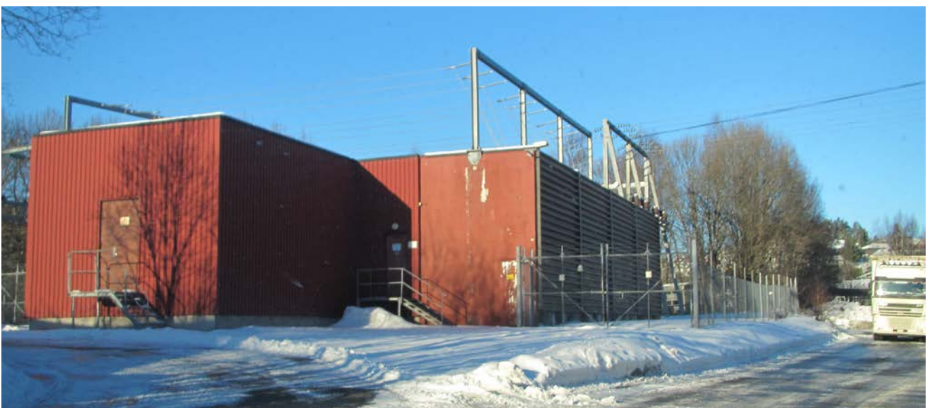
Sentralt plassert nord i den vestre delen av planområdet ligger Hafslunds store transformatorstasjon.
