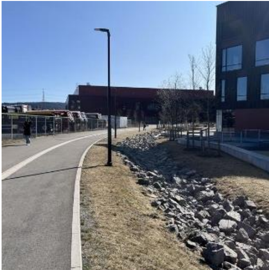
Figur 9 Flomvei ved nye Fjellhamar skole
