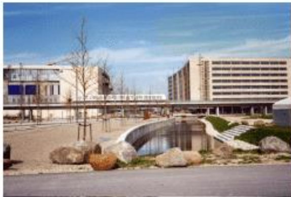
Figur 8 Kunstferdig utformet flomkanal (VA-miljøblad nr. 93)
