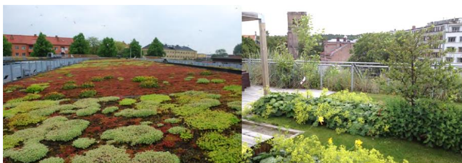
Figur 4 Eksempler på grønne tak. Til høyre vises et intensivt grønt tak i form av en takhage. Til venstre vises et ekstensivt grønt tak plantet med sedum (Noreng, K., Kvalvik, M., Busklein, J., Ødegård, I. M., Clewing, C. S., & French, H. K. (2012). Grønne tak.
