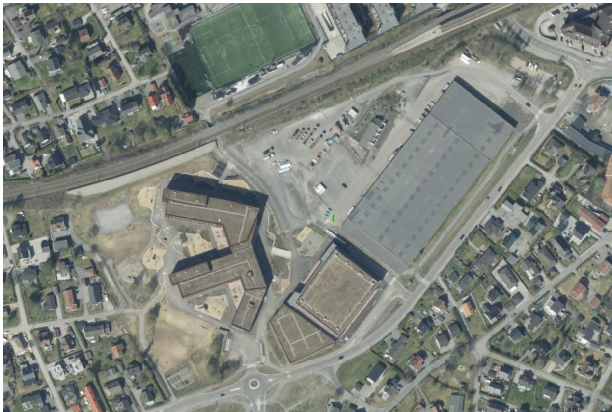
Bilde 4: Vesttomten med lagerbygg og parkeringsarealer til høyre. Fjellhamar skole til venstre. (Norge I bilder)
