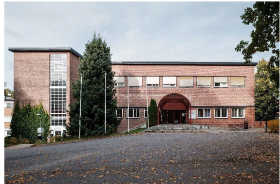
Bilde 2: Bygget Bruket Fjellhamar skal bevares
