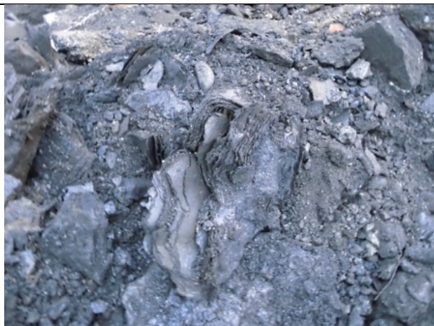
Foto 4. Avfallsinfiserte fyllmasser fra sjakt FS1. En pakke med takpapp er synlig midt i bildet.
