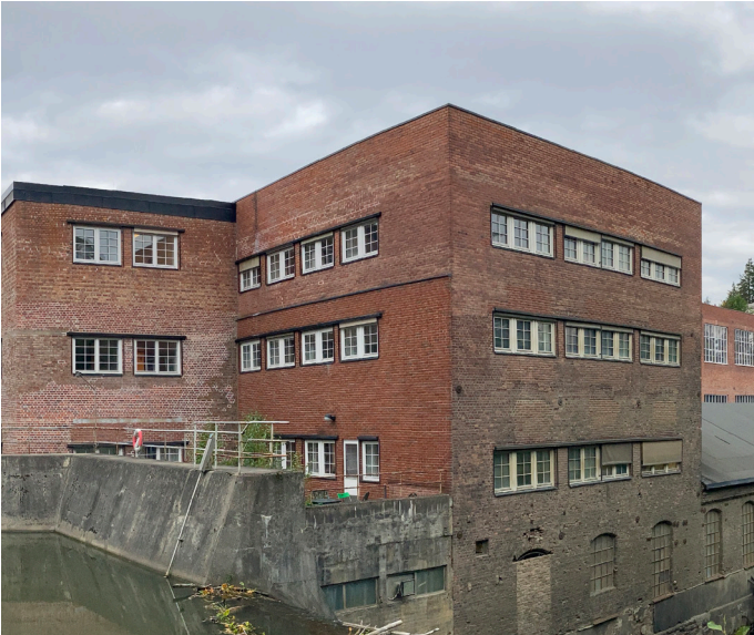
OMBYGGET FASADE PÅ ORIGINAL SOKKEL
