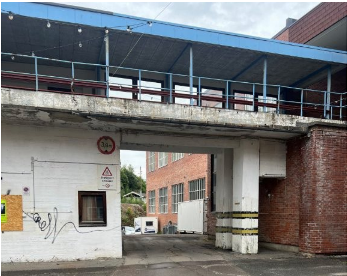
Figur 35: Sidesporet som er ført inn i bygningene på Fjellhamar bruk.
