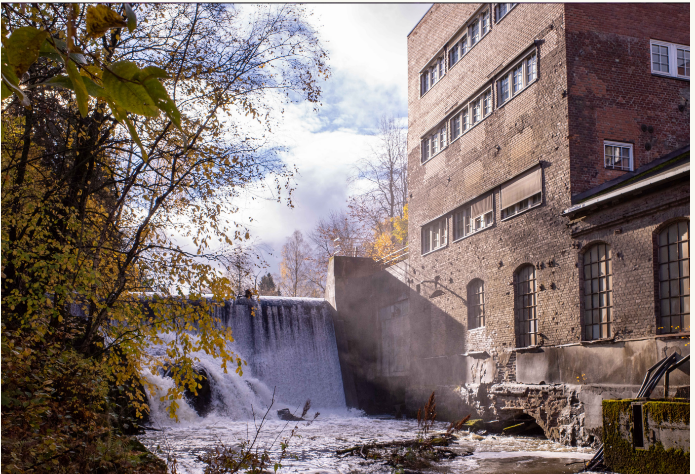
Papphuset med ombygget fasade på original sokkel 2022
