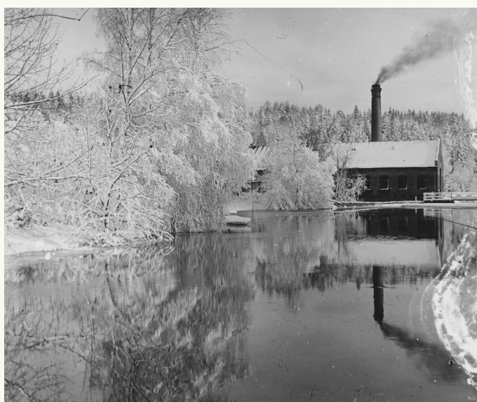
DET TIDLIGERE PAPPHUSET OG ELVEROMMET
