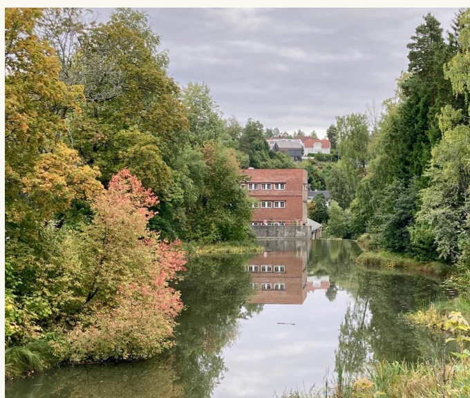
DAGENS SENTRALBYGG OG ELVEROMMET
