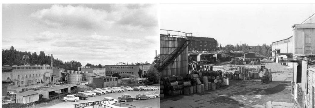
Figur 2 Foto fra Fjellhammar Brug 1968 /3/. Bildet til høyre viser tønnene som asfalten ble levert i.
