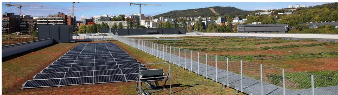
Figur 15: Solcelleanlegg på Motek der sedumtak er kombinert med solcelleanlegg i øst/vest-konfigurasjon. Hentet fra Bergknapp AS.
