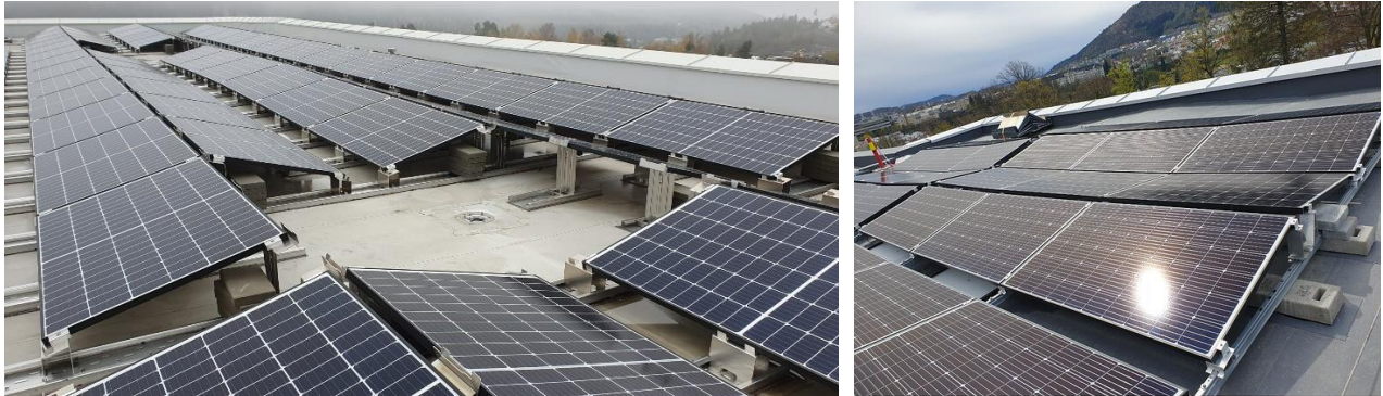
Figur 20: Eksempler på solcelleanlegg på blå tak med forhøyet montasjesystem ved bruk av hhv. spesialløsning og stein (kilde: Norconsult og FUSen).
