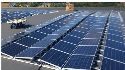
Figur 14: Solcelleanlegg på flatt tak med øst/vestkonfigurasjon.
