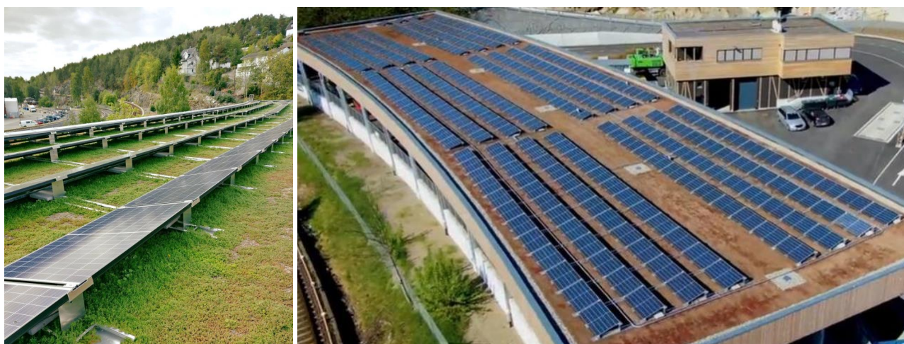
Figur 17: Hentet fra Energima Solel, Ryen Gjenbruksstasjon. Et eksempel på et grønt tak med sydvendt solcelleanlegg.
