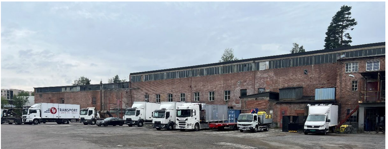
Figur 56: Bygg som foreslås revet: Takpappfabrikken.
