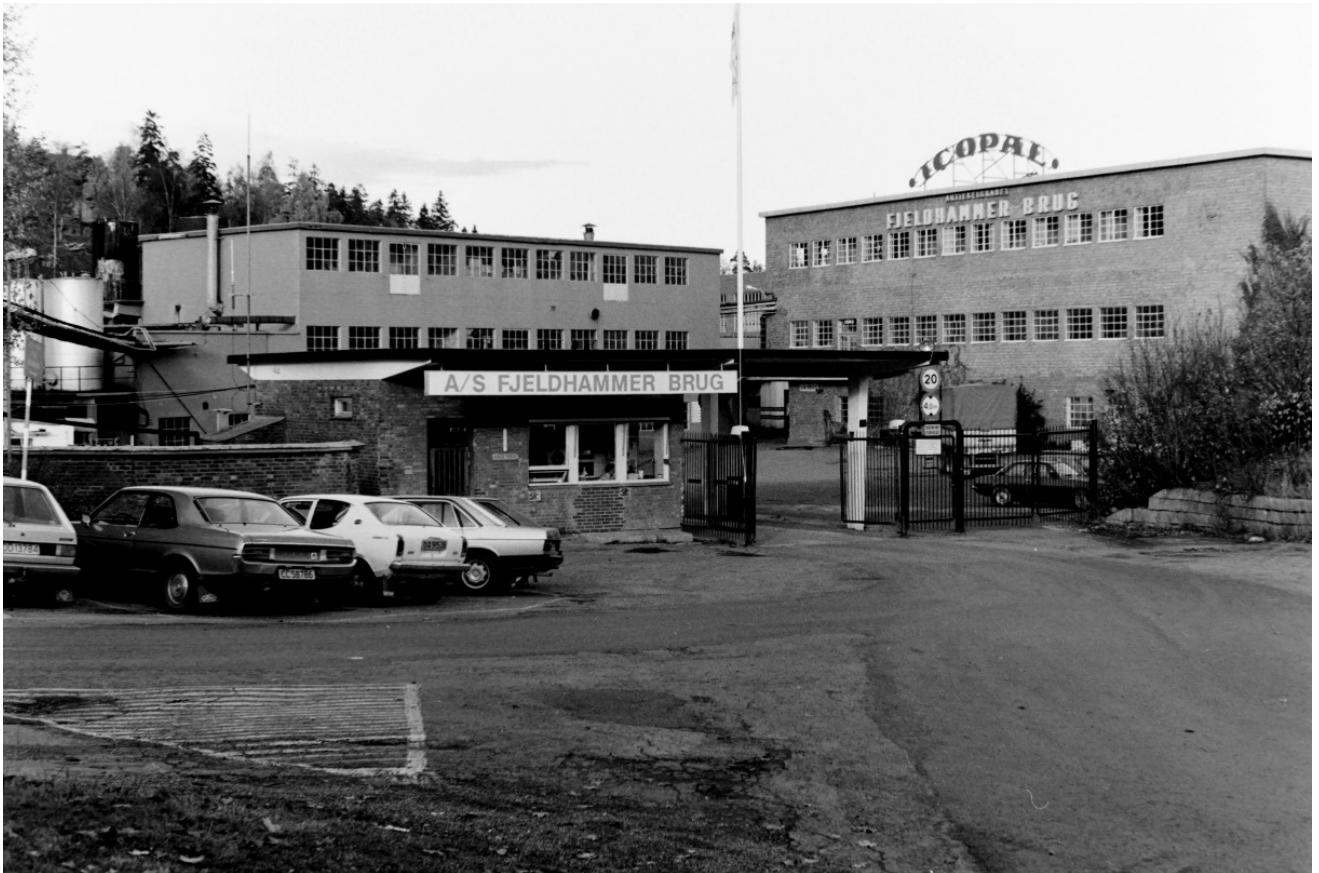
Figur 41: Portvakten, verkstedet og administrasjonsbygget. Kilde: Solon eiendom/Fjellhamar utvikling.
