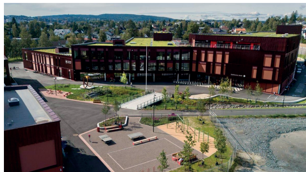
Nye Fjellhamar skole og arena ble ferdigstilt og åpnet i 2023. Foto: Lørenskog kommune
