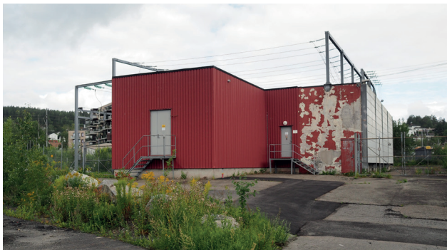
Trafostasjon på det vestre delområdet. Nedlegging av høyspentlinje til kabeltrase under bakken medfører behov for flere stativer utendørs, dersom ikke hele trafoen ombygges til et kompaktanlegg.
