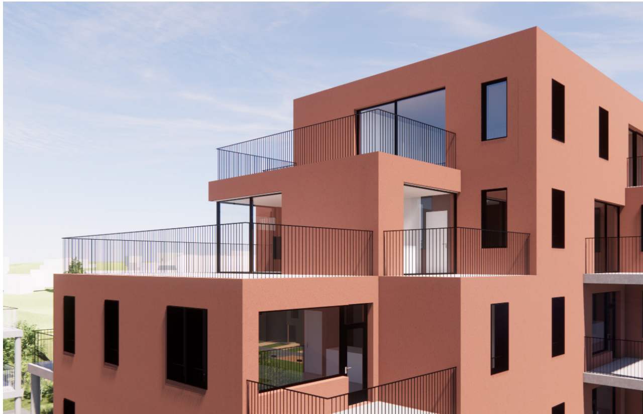
Fasadeinntrekk (4 og 5 etg)
