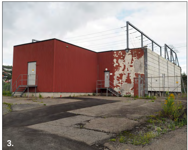
Transformatorstasjon i vestre del (Foto: Lala Tøyen)
