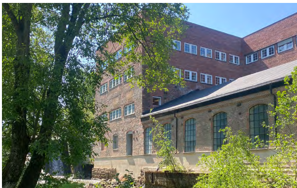
Pappbygningen og maskinhallen på Fjellhamar Bruk fra elvesiden (Foto: Lala Tøyen)
