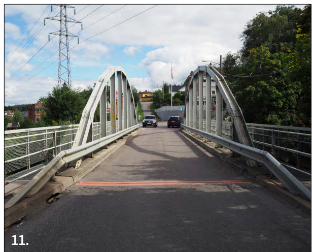
11. Bru over Fjellhamarelda (Foto: Lala Tøyen)
