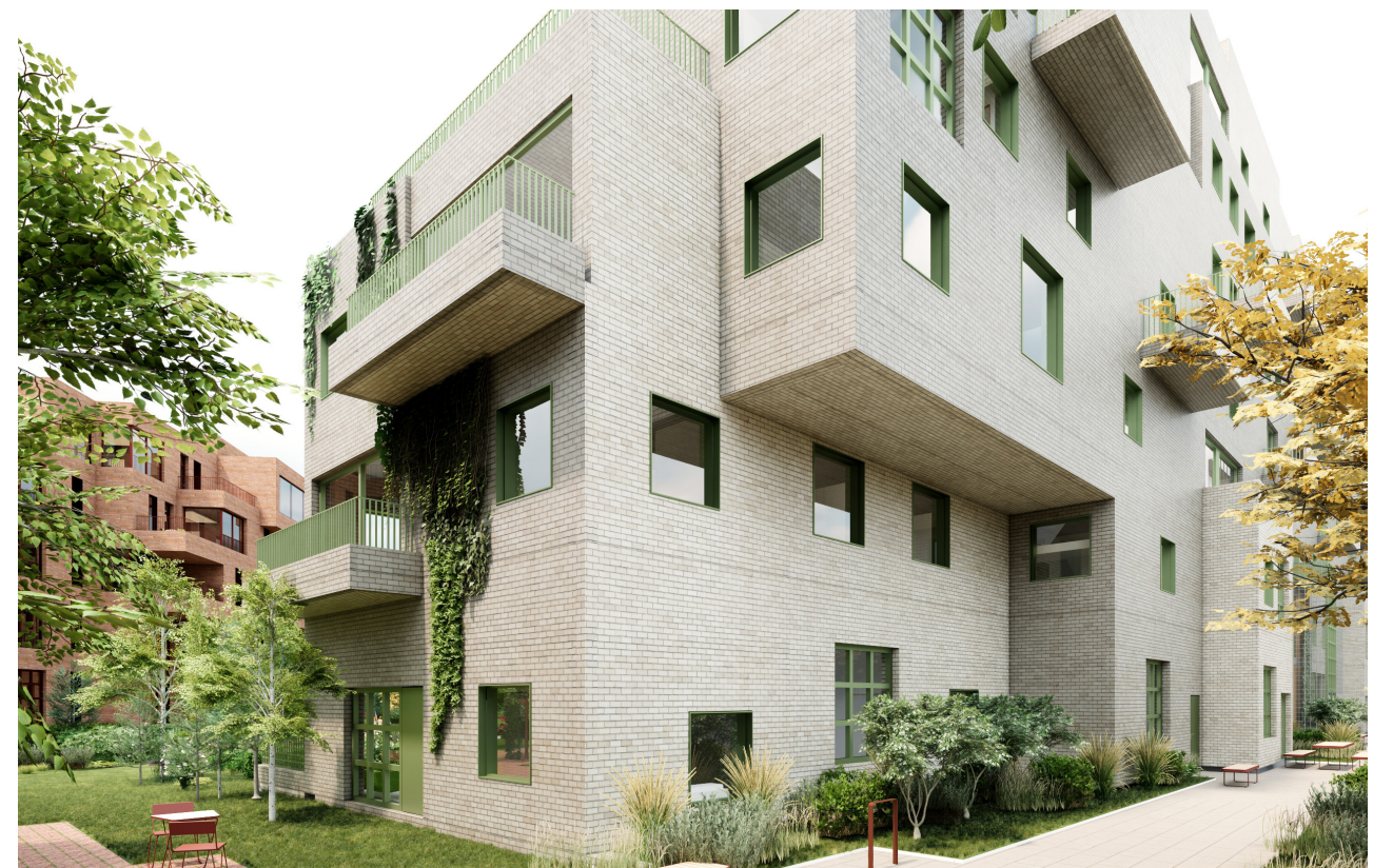
To etasjes tilbygg / sprang i vegg/liv (bakkeplan)
